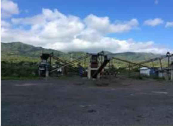
Photo 27 : Exploitation d'une carrière à l'aéroport
