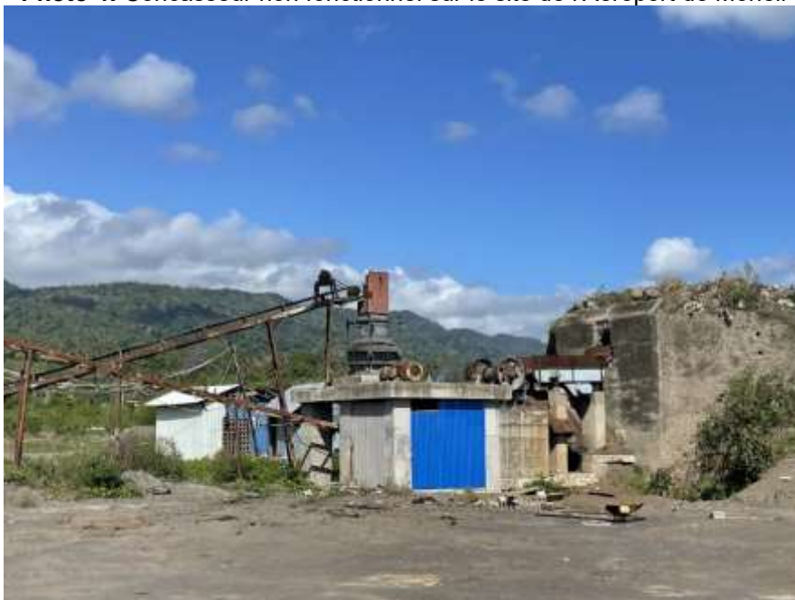
Photo 4: Concasseur non fonctionnel sur le site de l'Aéroport de Mohéli
