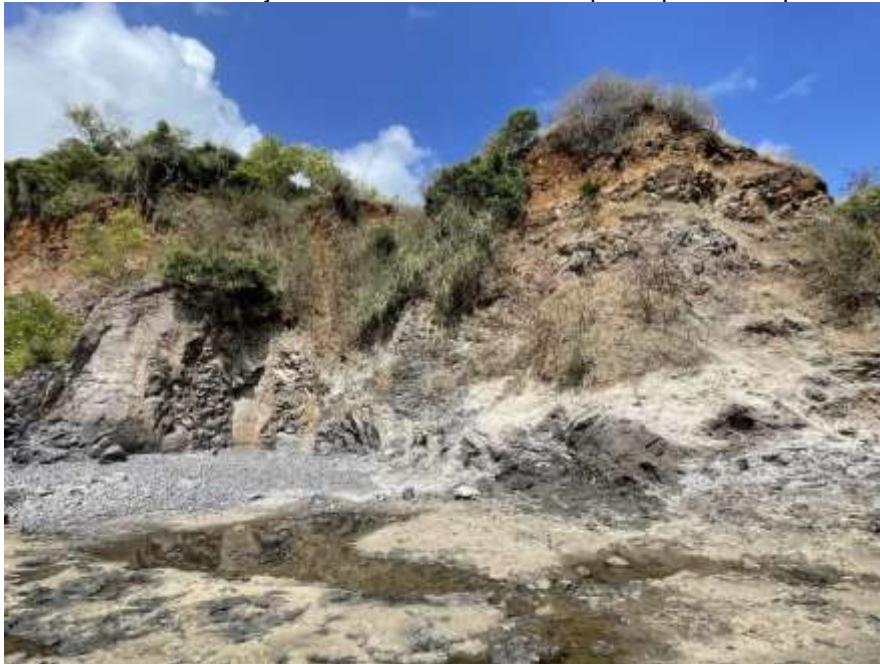
Photo 3: Site de Komdjou Côtier anciennement exploité par l'Entreprise Colas
