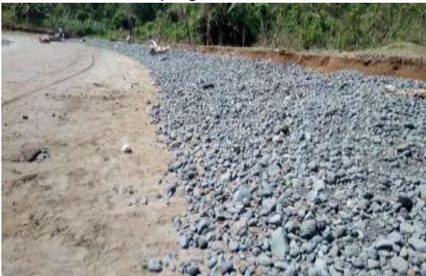
Photo 11 : Digue naturelle en enrochements basaltiques sur Komoju côtier
