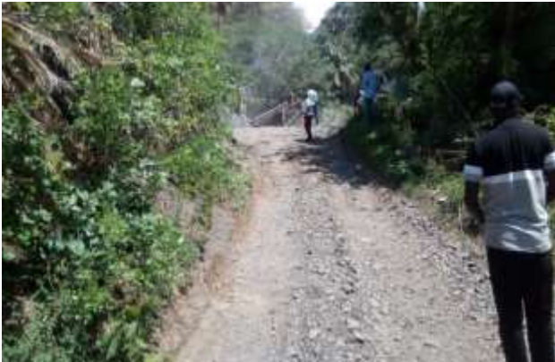
Photo 21 : Chemin d'accès à la carrière de concassage de Domoni-Hoani
