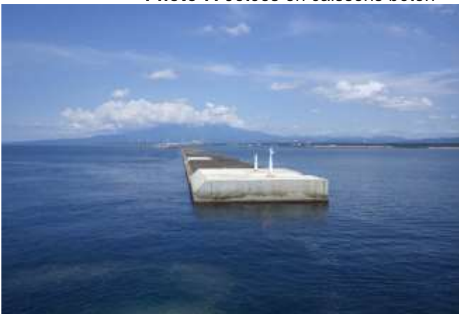
Photo 7: Jetées en caissons béton
