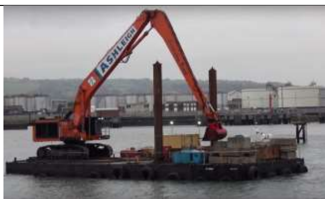
Photo 9 : Excavatrice sur ponton flottant
